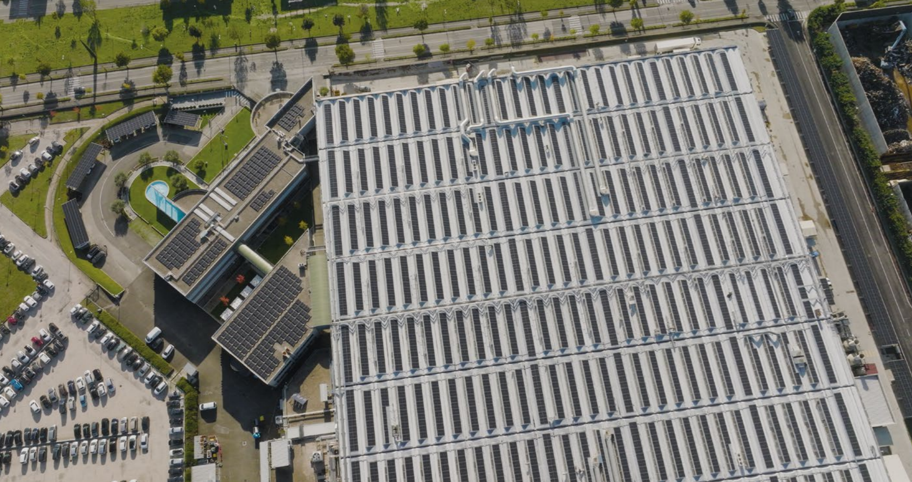
Nelle foto a lato e sotto: I pannelli fotovoltaici installati sul tetto della casa madre di Foligno.
